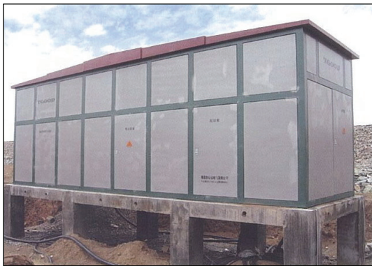
(青藏铁路箱式变电站)
