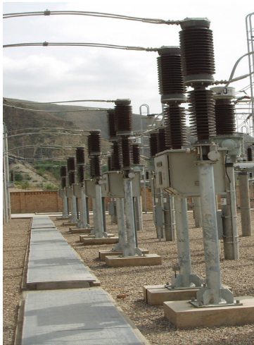
(VBK2 55kV 大秦重载货运专线)
