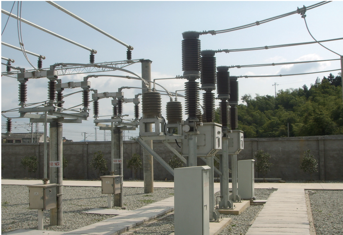
上图为 AEVK I 型 2 \times 27.5 kV 户外真空断路器
